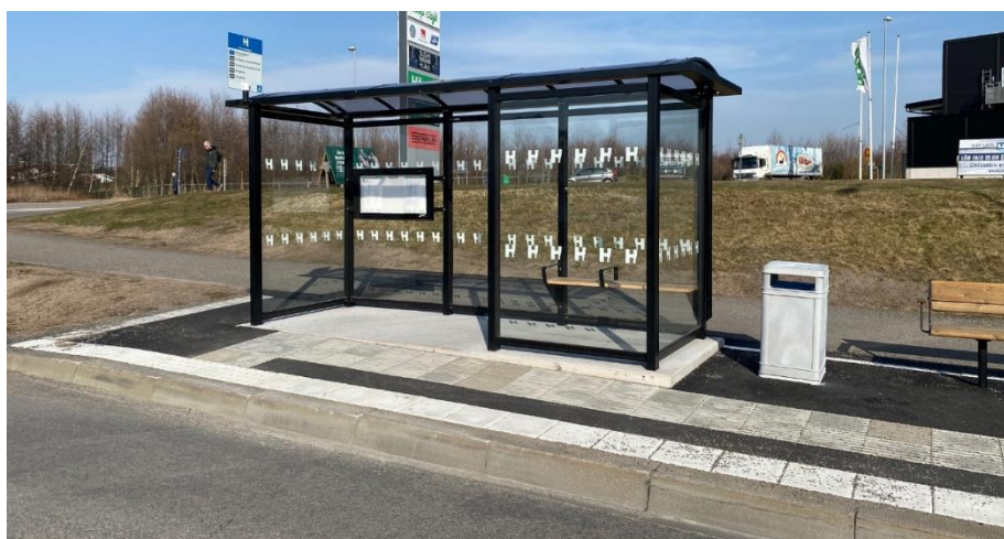
Hållplats Vrångagatan, Varbergs kommun
